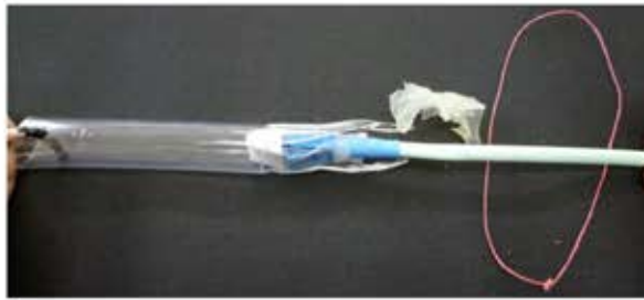
⑩ 透明外套チューブ内から光コネクタを取り出す
